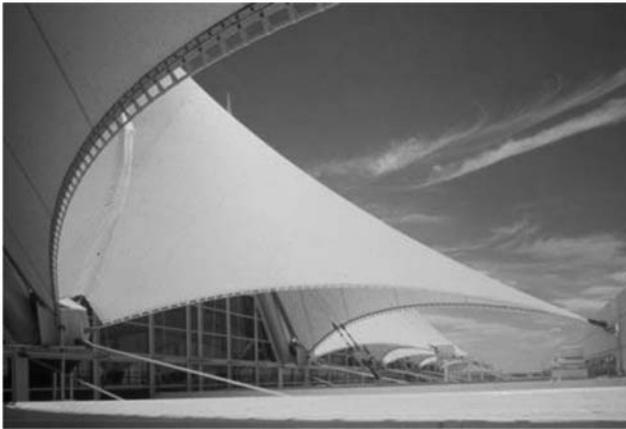
Fig. 14. Anchorage and Edge Catenaries
